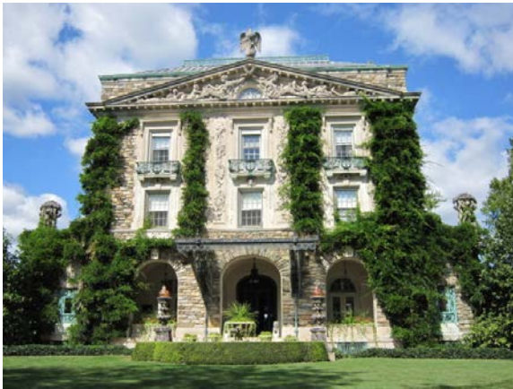
図1. ロックフェラー邸の写真
